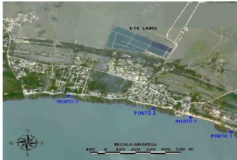
Figura 26A - Estação de Tratamento de Esgoto – LAMI Fonte: Dmae/RS/2004
