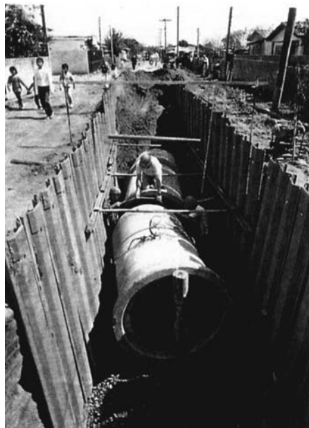
Figura 3 - "A falta de redes de tratamento de esgoto, um problema sério no Brasil e América Latina" Fonte: Projeto Pró-Guaíba/RS
