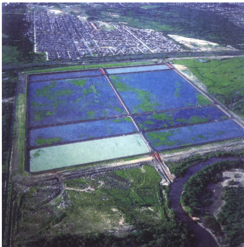
Figura 22 - Estação de Tratamento de Esgotos (ETE) de Cachoeirinha – Obra do I Módulo do Pró-Guaíba.
