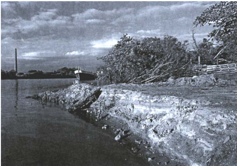
Figura 14 - Assoreamento. Margem agredida absorve tudo o que as chuvas trazem, como lixo e veneno, das lavouras e indústrias. Fonte: Pró-Guaíba/RS
